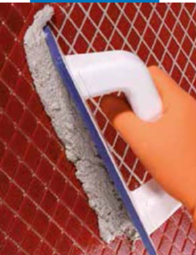
Нанесение Kerapoxy Design плоским резиновым шпателем
