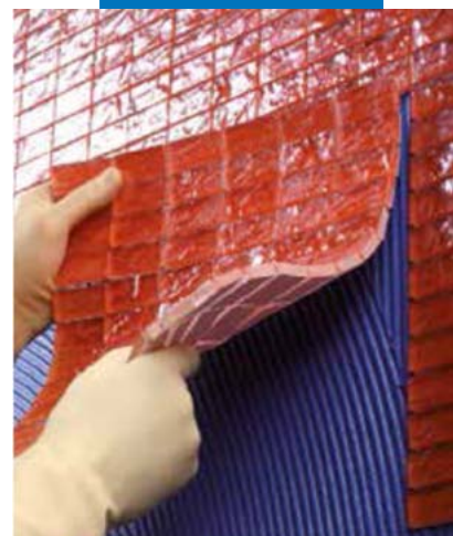
Укладка стеклянной мозаики с помощью Керароху Design на стены
