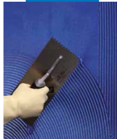
Нанесение Керароху Design синего цвета в качестве клея при помощи зубчатого шпателя
