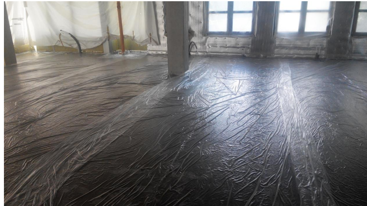
Защита поверхности стяжки пленкой
