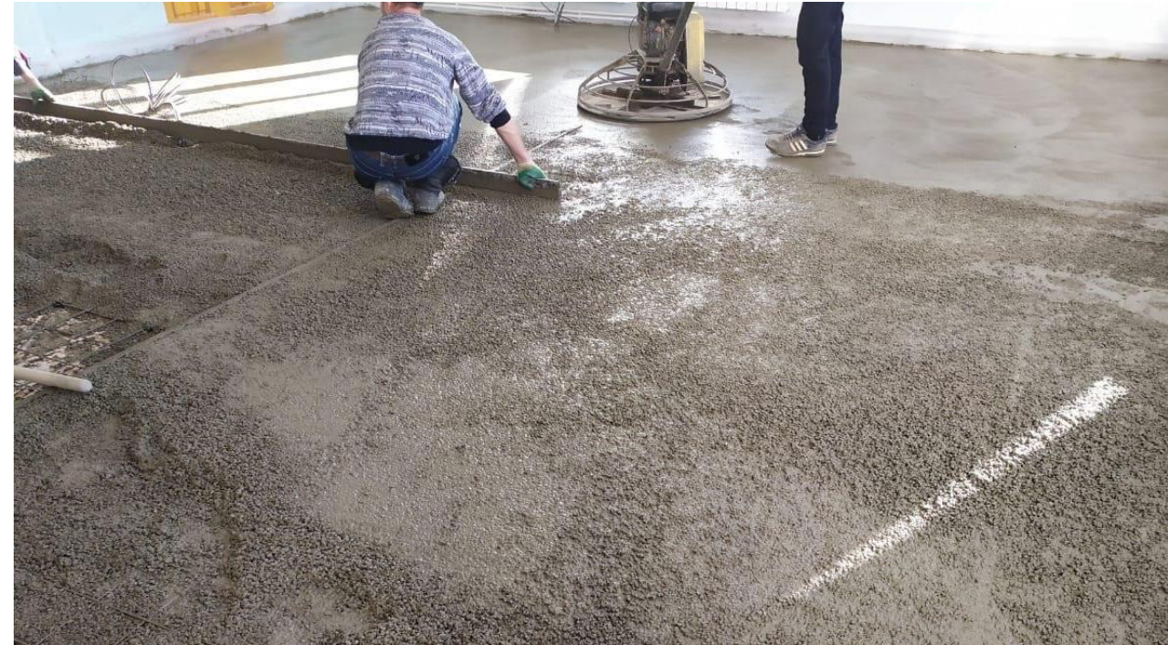
Распределение материала с помощью правила
